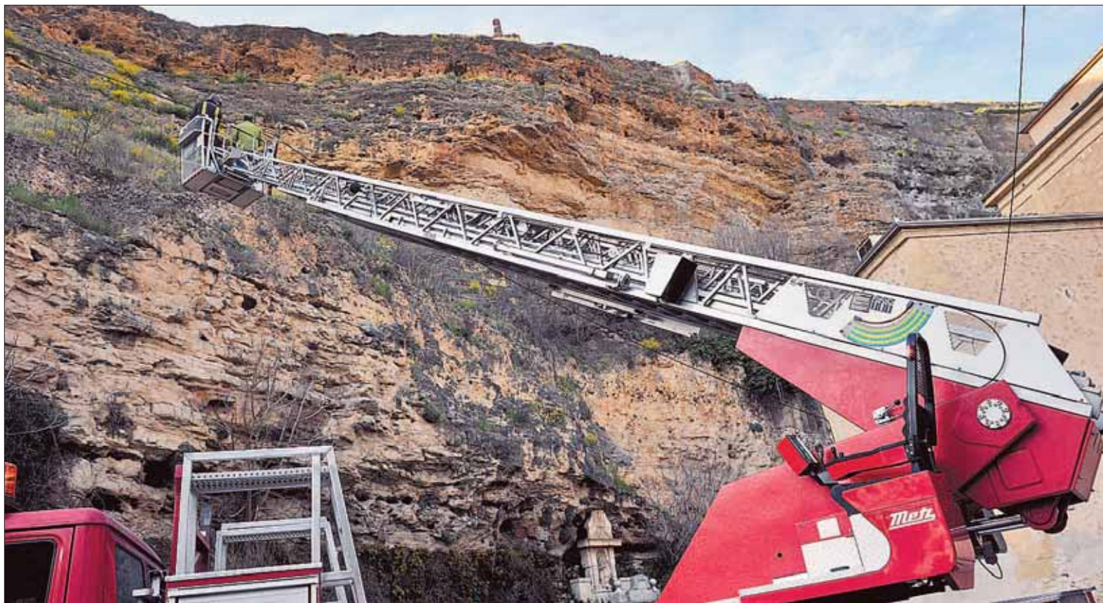
Los bomberos de Segovia desplazaron hasta el lugar un camión con escala para comprobar el estado del talud en el lugar del desprendimiento. / KAMARERO
