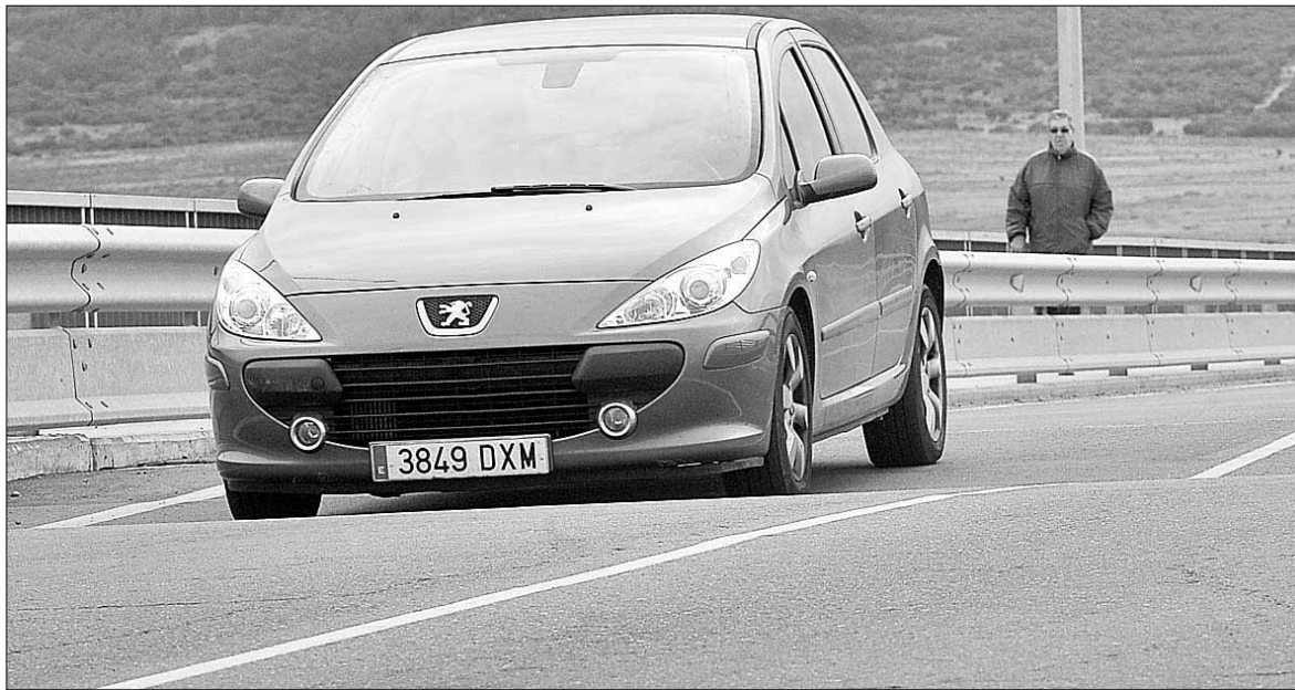
El hundimiento de la calzada se aprecia especialmente en la zona del puente que sortea la variante SG-20. / KAMARERO
