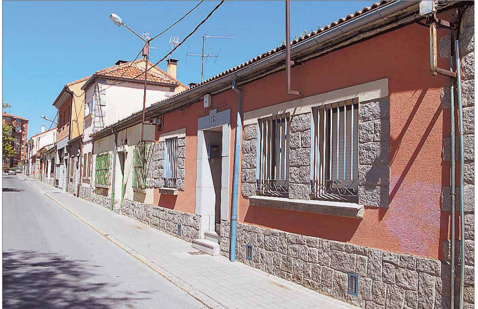
El Carmen es una zona de casas bajas y unifamiliares, muchas de ellas construidas durante los años de posguerra con ayudas públicas. / GONZALO AYUSO
