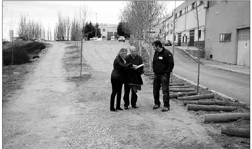
La concejala Paloma Maroto (izq.), inspeccionando los trabajos con los responsables de la obra. / EL ADELANTADO
