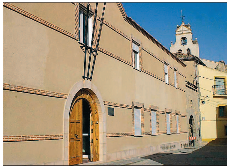
Fachada del Juzgado de Santa María la Real de Nieva. / EL ADELANTADO
