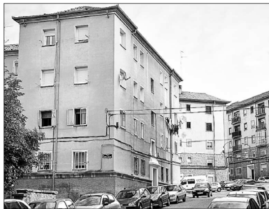
El estudio se podrá extrapolar al conjunto de edificaciones de San José. / KAMARERO
