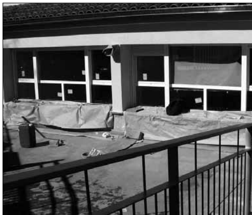
Las obras de la nueva Guardería infantil continúan su marcha. / A.P.
