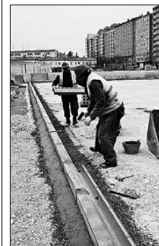
Trabajadores de obra civil.
