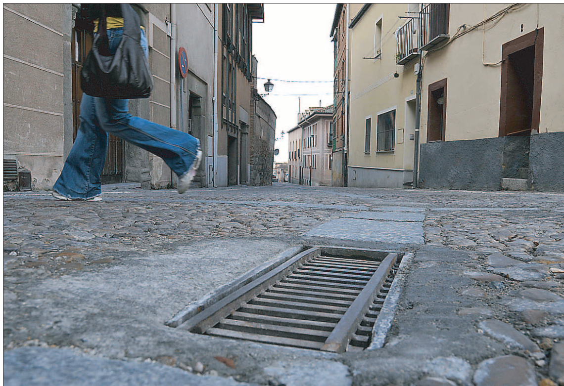
Imagen de la calle San Quirce, desde la plaza de San Nicolás, que estará en obras en breve. / JUAN MARTÍN
