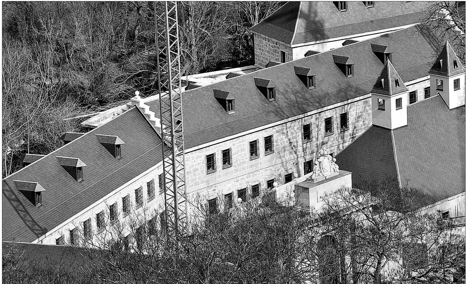
La Casa de la Moneda comienza ya a lucir un renovado aspecto. Las previsiones son que el grueso de las obras estén acabadas este próximo verano. /KAMARERO
