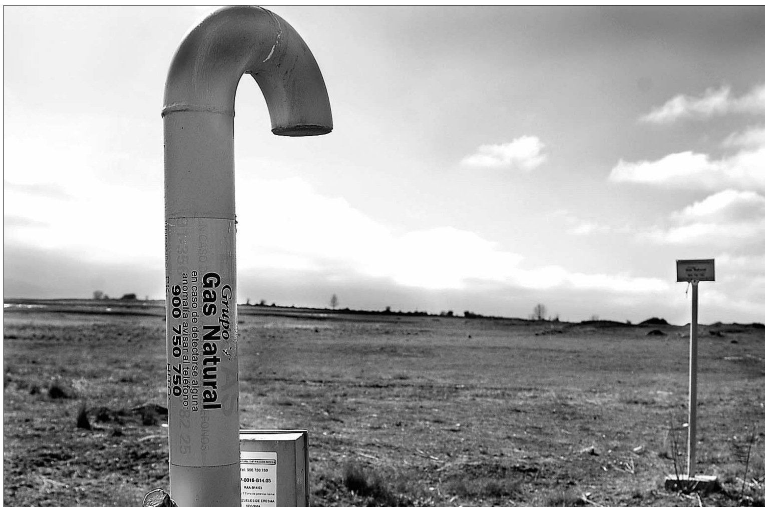
La nueva infraestructura partirá del gasoducto que ya abastece a la capital segoviana, en Palazuelos de Eresma. /ALBERTO BENAVENTE
