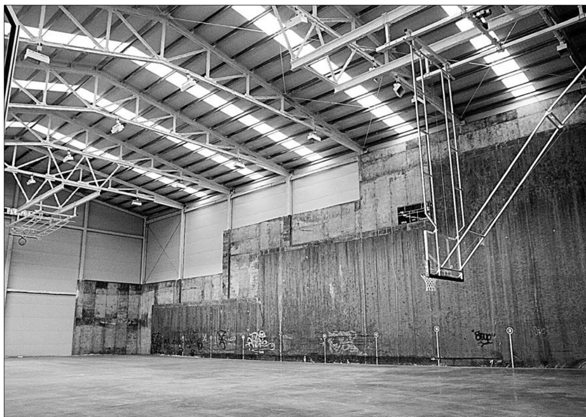
La segunda fase de actuación sobre el frontón permitirá que la nueva instalación pueda utilizarse. / GABRIEL GÓMEZ
