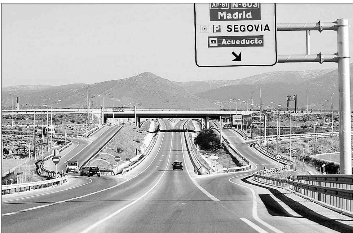
Fomento ha aprobado ya el desdoblamiento de la carretera SG-20, con un presupuesto de 63,7 millones de euros./KAMARERO
