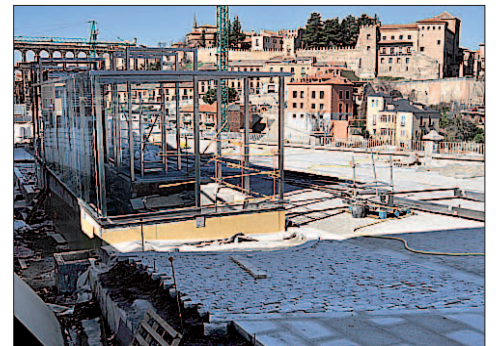
Estado actual de las obras del parking. / KAMARERO
