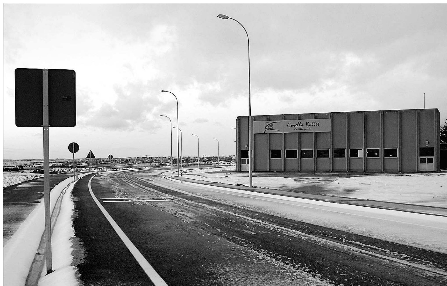
Imagen del tramo de la carretera ya construido (entre Femsa y el valle del Eresma), que conectará con el puente proyectado sobre el río. / JUAN MARTÍN
