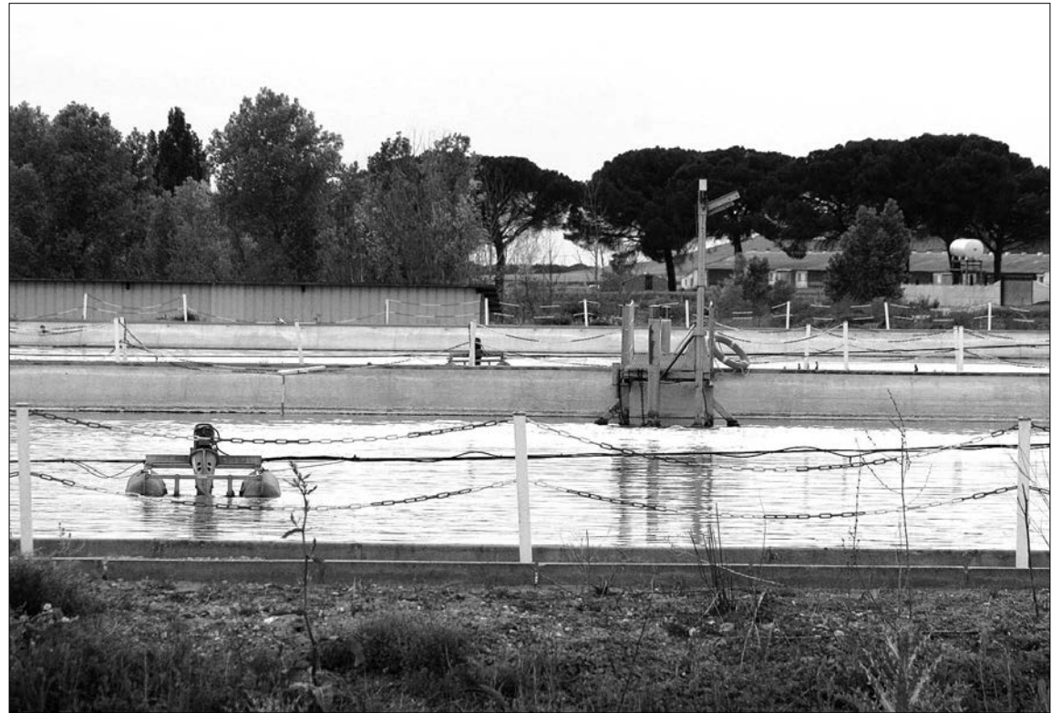
Estación depuradora de aguas residuales de la villa./GABRIEL GÓMEZ
