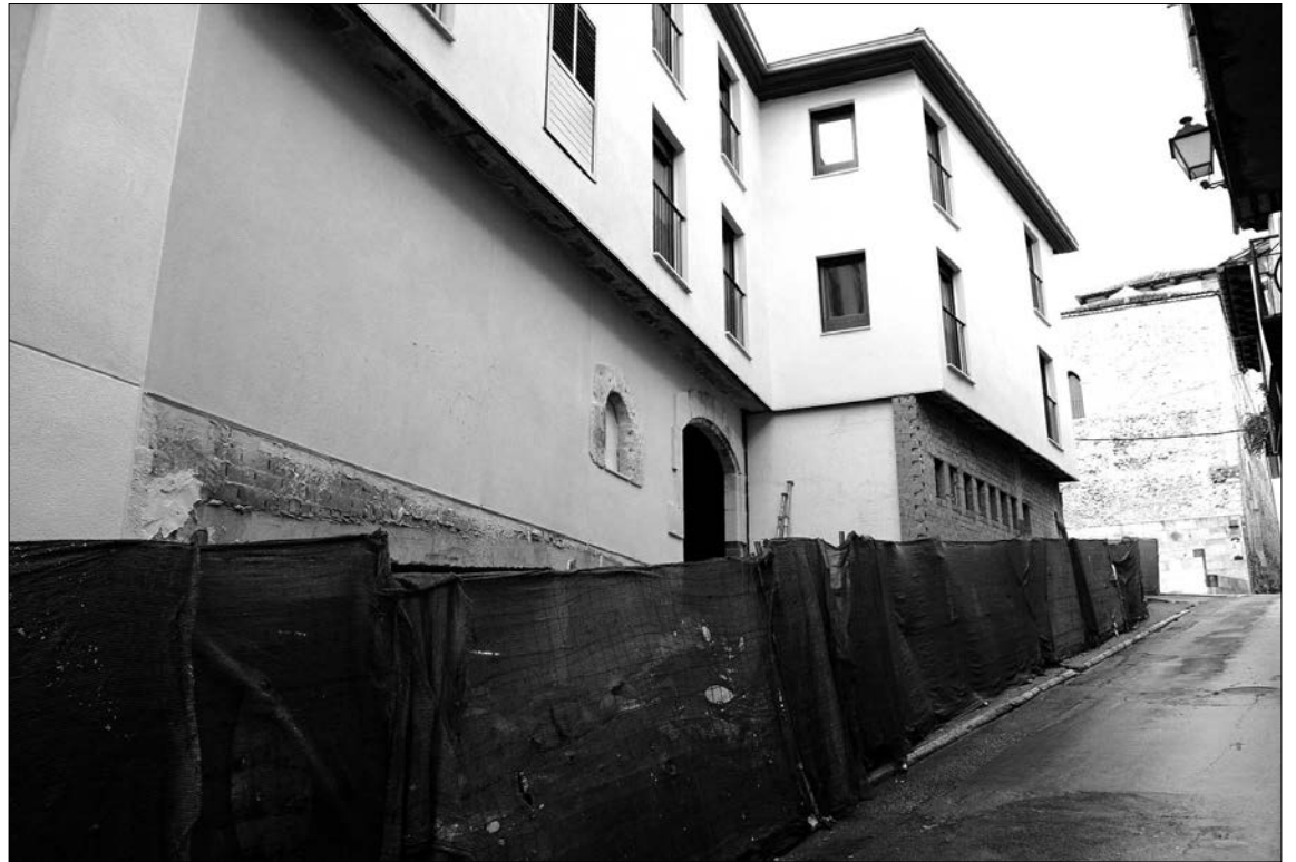
Los primeros trabajos comenzarán esta semana en la calle Colegio./GABRIEL GÓMEZ
