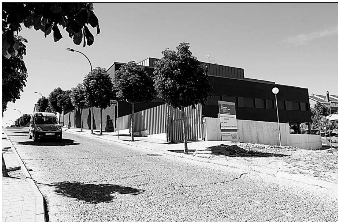
Entre los proyectos se encuentra la adecuación de la calzada y la acera de la calle Botiller./GABRIEL GÓMEZ
