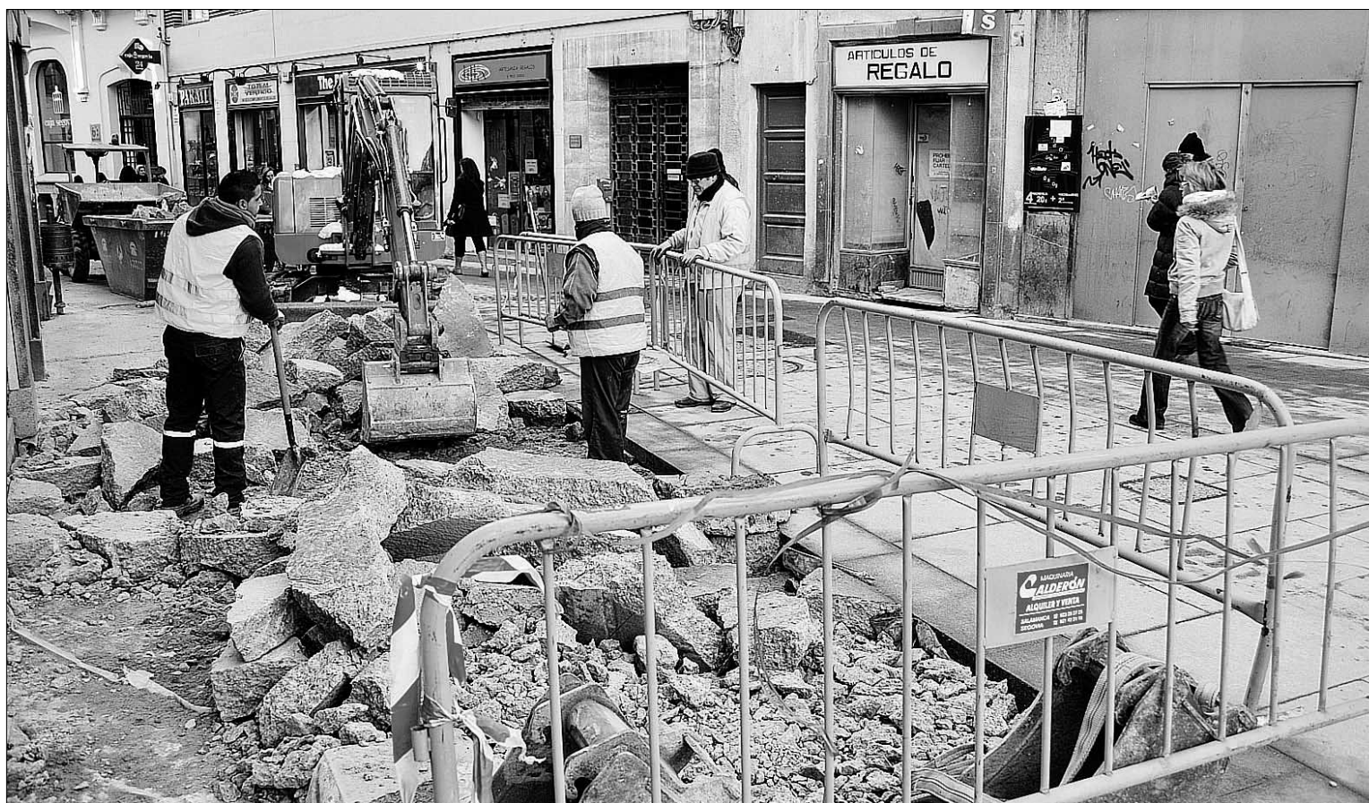
Las obras han permanecido paradas durante más de veinte días para no obstaculizar el tránsito de peatones durante las fiestas navideñas. / KAMARERO
