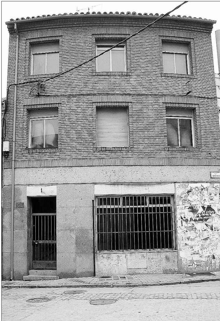
Edificio que acogerá el futuro centro cultural de Carbonero el Mayor. / EL ADELANTADO
