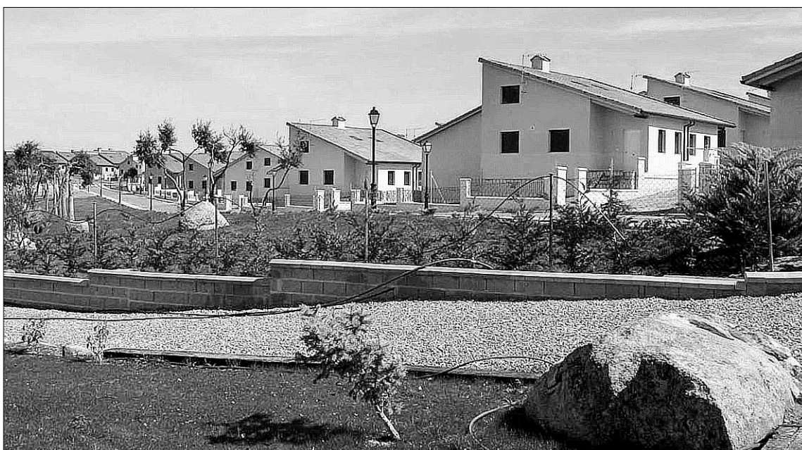
Urbanización en la proximidad de la N-VI, municipio de Ituro y Lama, cuya población casi se ha duplicado. / F. PEÑALOSA
