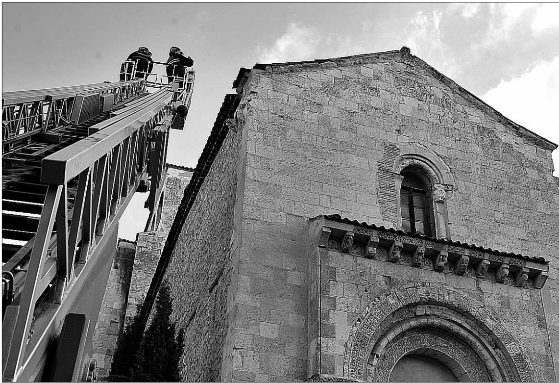
El pasado 19 de diciembre se desprendieron varias piedras de la cornisa de la iglesia de San Clemente./KAMARERO
