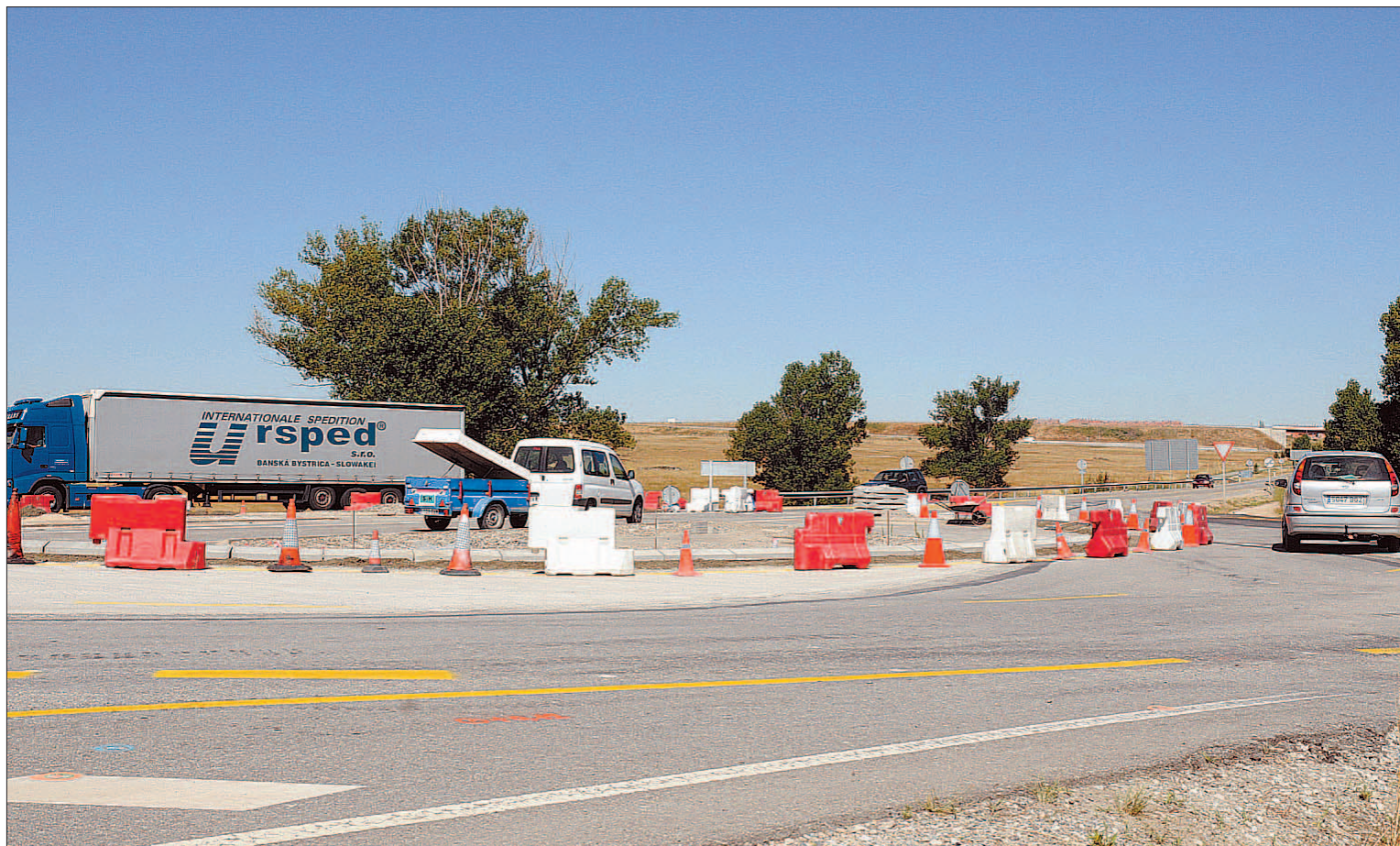
Estado actual de las obras de la rotonda que lleva a las destilerías DYC y a los núcleos de Palazuelos y Tabanera. / BEATRIZ VELASCO
