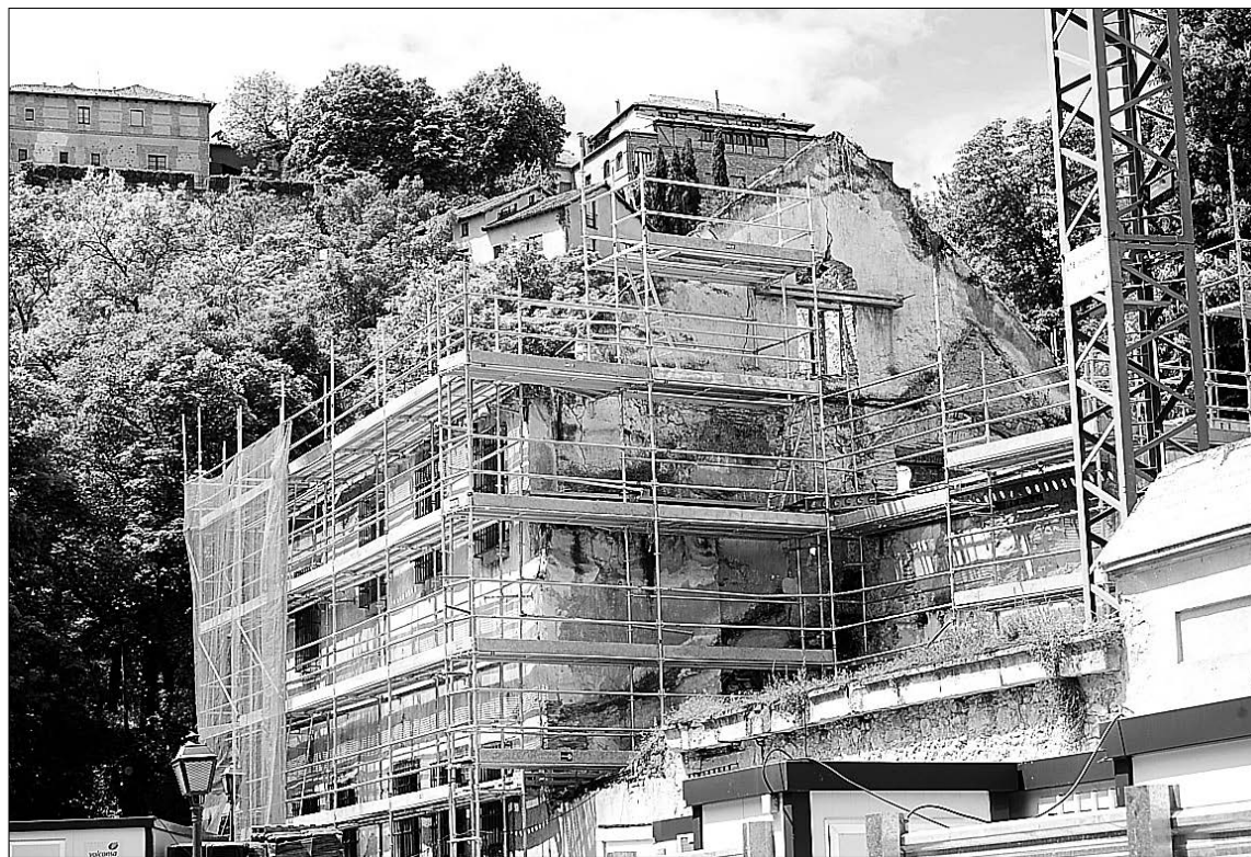
Las obras de rehabilitación de la Casa de la Moneda continúan a buen ritmo. / KAMARERO
