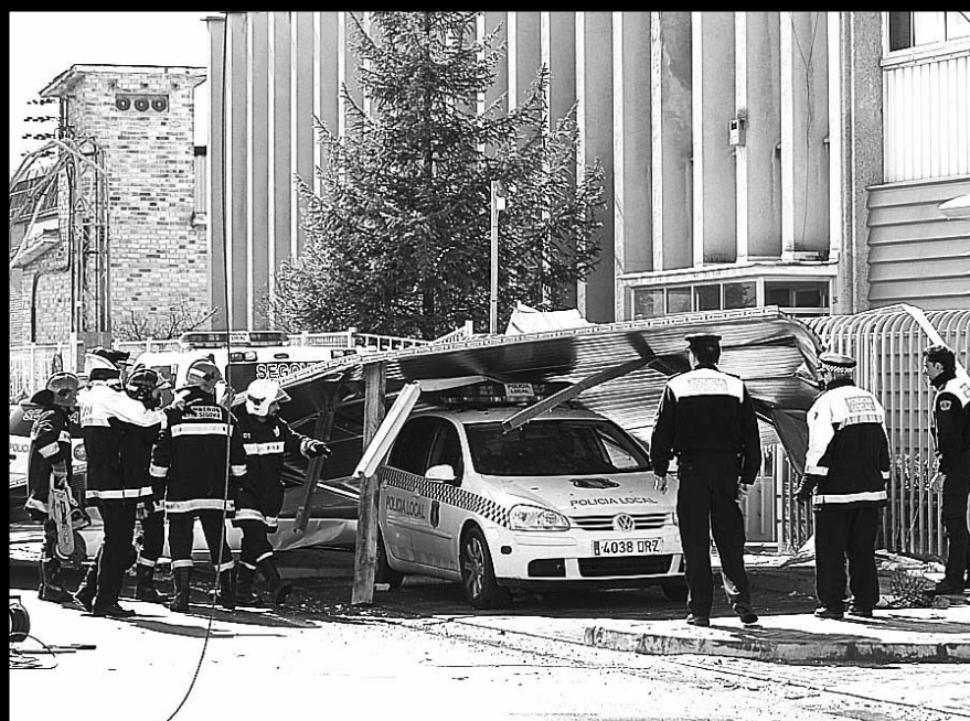
El fuerte viento derribó en marzo parte de la cubierta del cuartel de la Policía Local de Segovia, en el polígono de El Cerro impactando sobre la calle Guadarrama y golpeando a un vehículo que transitaba por dicha vía, así como a unos seis vehículos que se encontraban estacionados.
