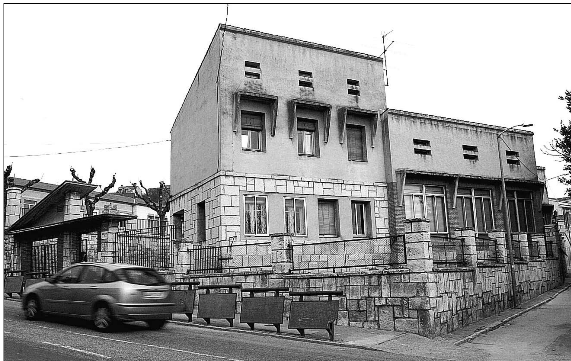
Edificios que serán demolidos para la construcción de las nuevas instalaciones en el CEIP LA Villa
