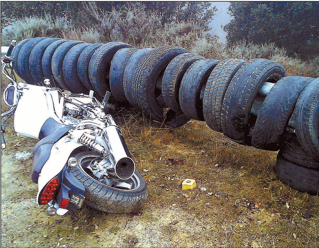
Instalación del sistema inventado por Casto Calle Monasterio para amortiguar el golpe de los motociclistas al salirse de la vía. / ICAL
