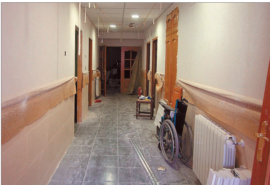
Una de las estancias de la residencia, actualmente en obras. / FERNANDO PEÑALOSA
