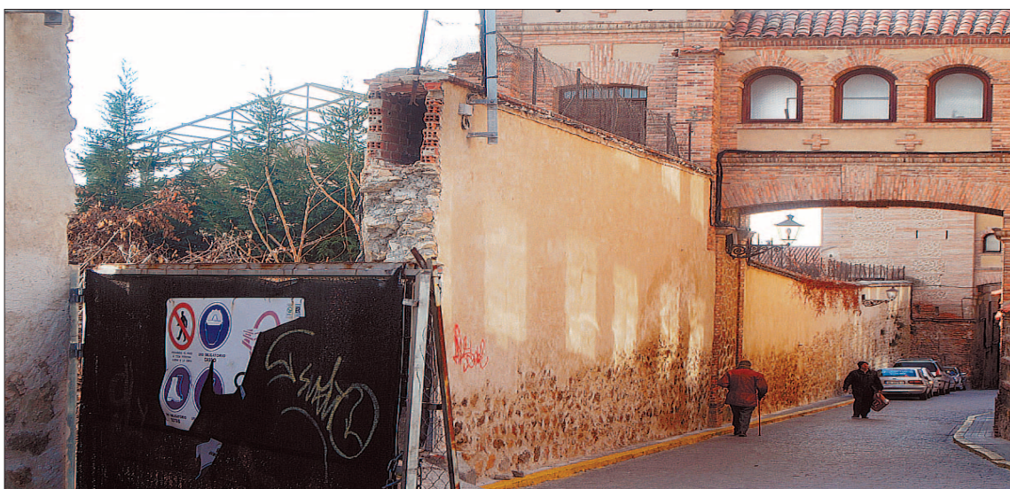
A la izquierda, cerchas de la cubierta del Cervantes que serán retiradas en los próximos días /KAMARERO
