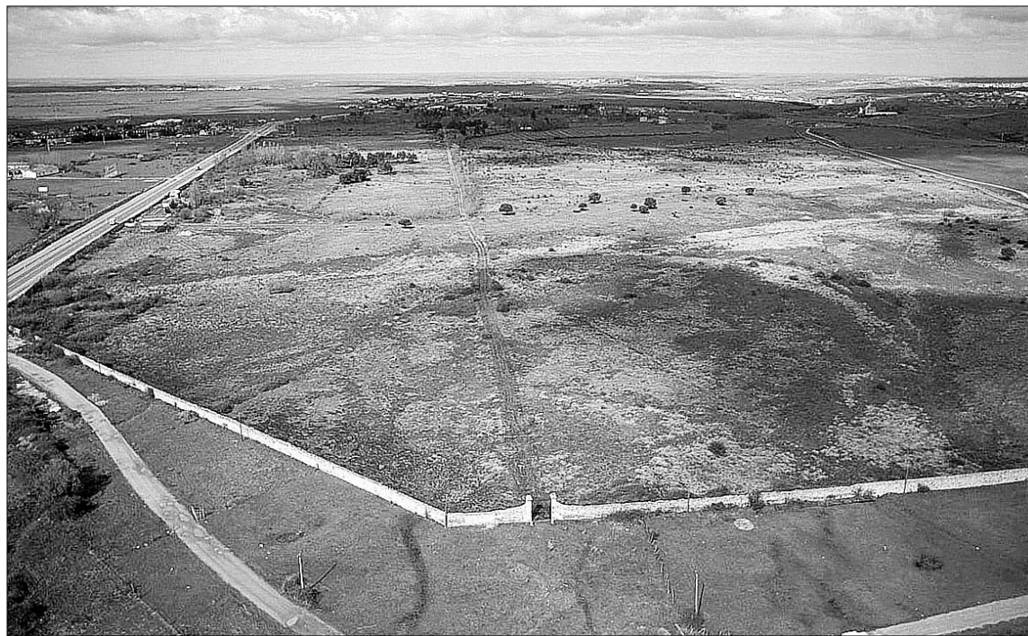
Estado que presentaba la finca de Quitapesares antes de que comenzaran los trabajos de Segovia 21./EL ADELANTADO
