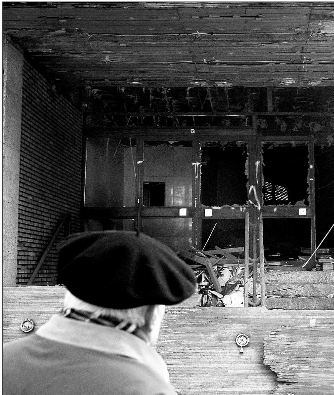
Un hombre contempla los daños causados por la bomba en la entrada de los juzgados de Sestao. / VINCENT WEST (REUTERS)
