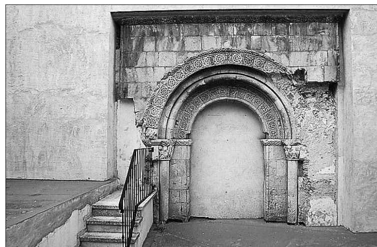
Muro y arco románico localizados en la primera intervención./KAMARERO
