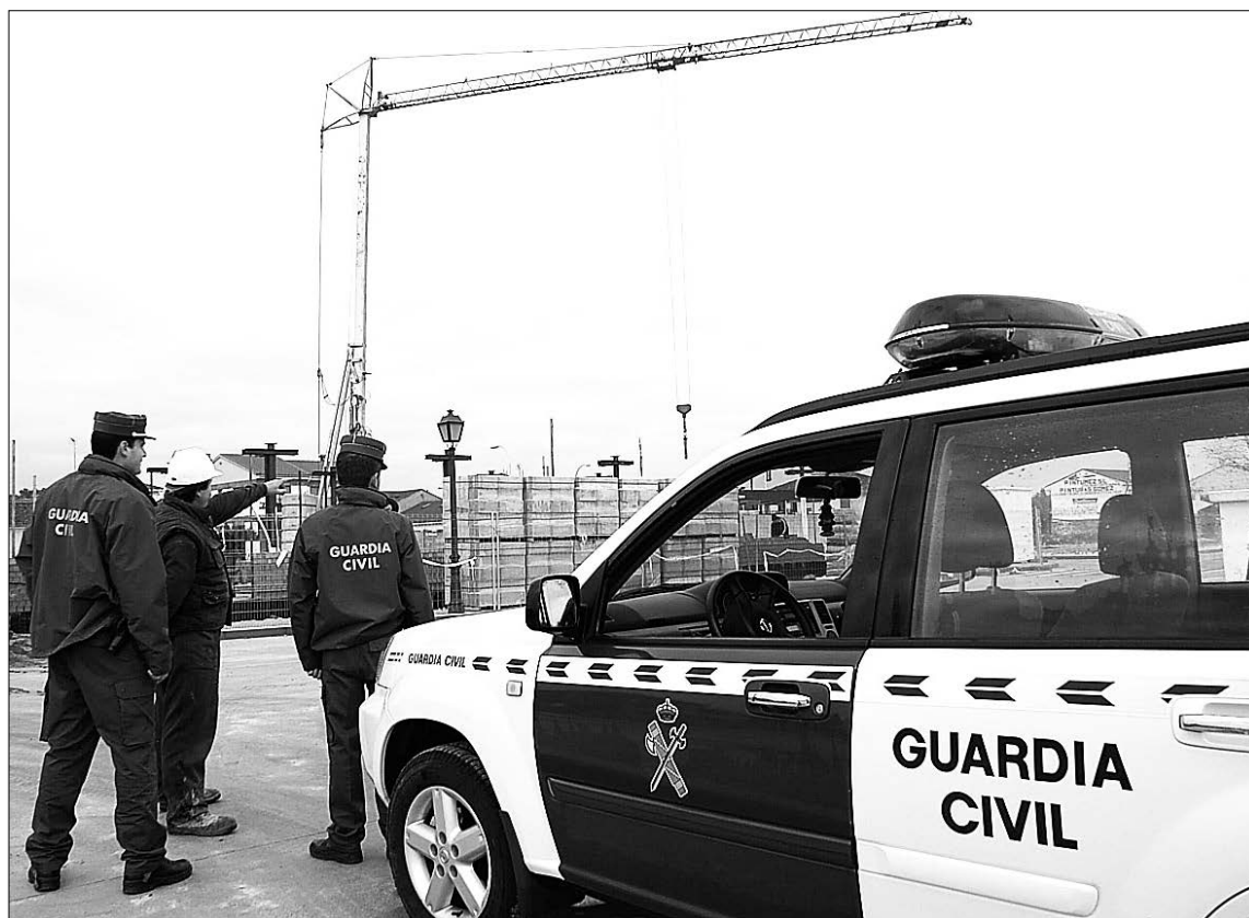
Miembros de la Guardia Civil vigilan obras, en las que trabajan numerosos inmigrantes. / EL ADELANTADO
