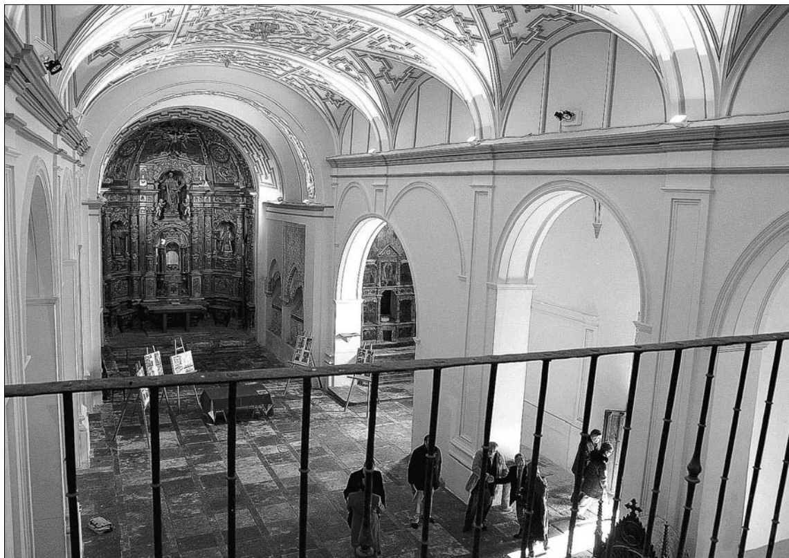
Nueva imagen del interior del templo tras las obras de restauración acometidas./GABRIEL GÓMEZ
