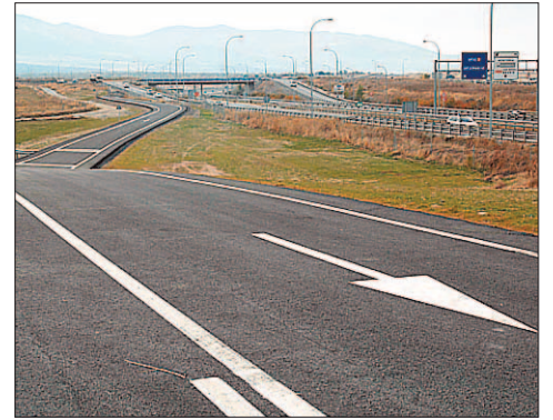
Vial de acceso a la nueva estación del AVE./ J..M.
