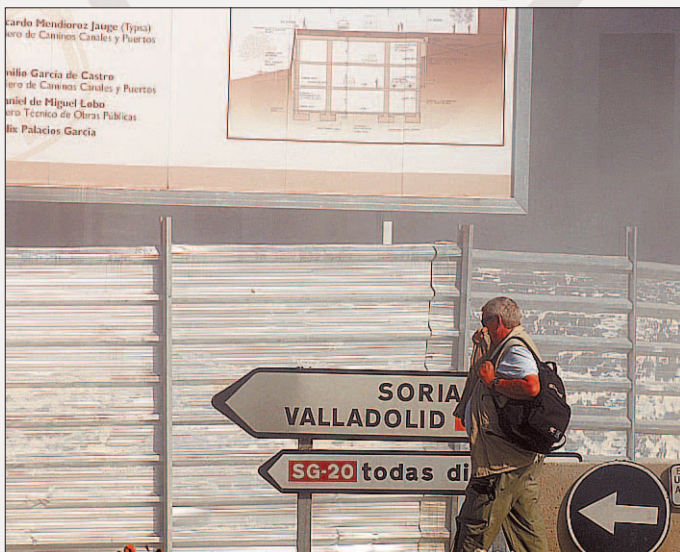
Obras del aparcamiento de la avenida de Padre Claret. / KAMARERO
