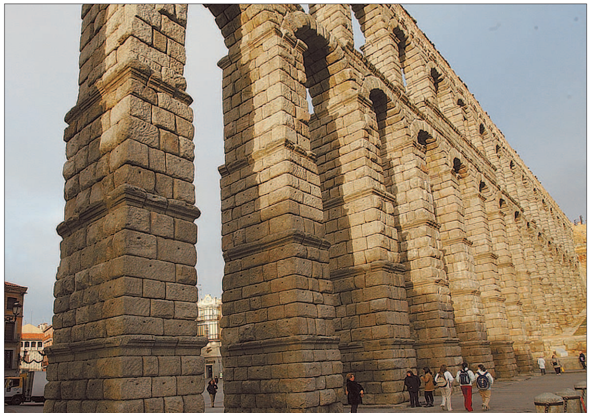
El objeto de la prospección solicitada y denegada es detectar las fases de utilización del monumento romano./PEÑALOSA
