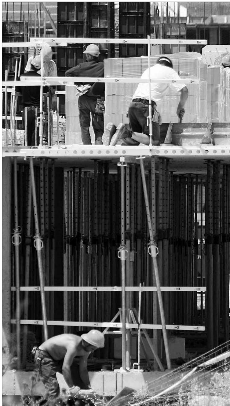
Unos albañiles trabajan en la construcción de un edificio. / DAVID CASTRO
