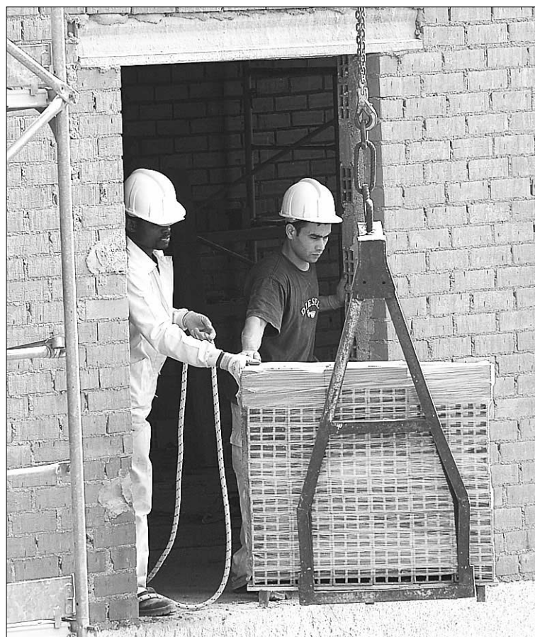
La demanda de la construcción se ha visto mermada. //JUAN MARTÍN
