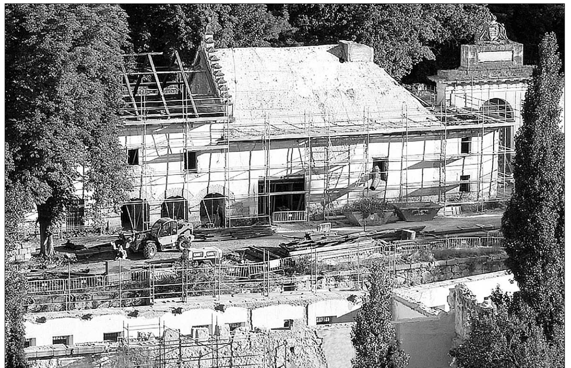
La asociación renonece que las obras de la Casa de la Moneda van a buen ritmo. / JUAN MARTÍN
