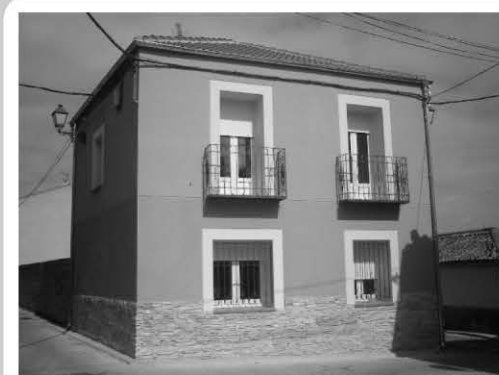
Detalle de la fachada
