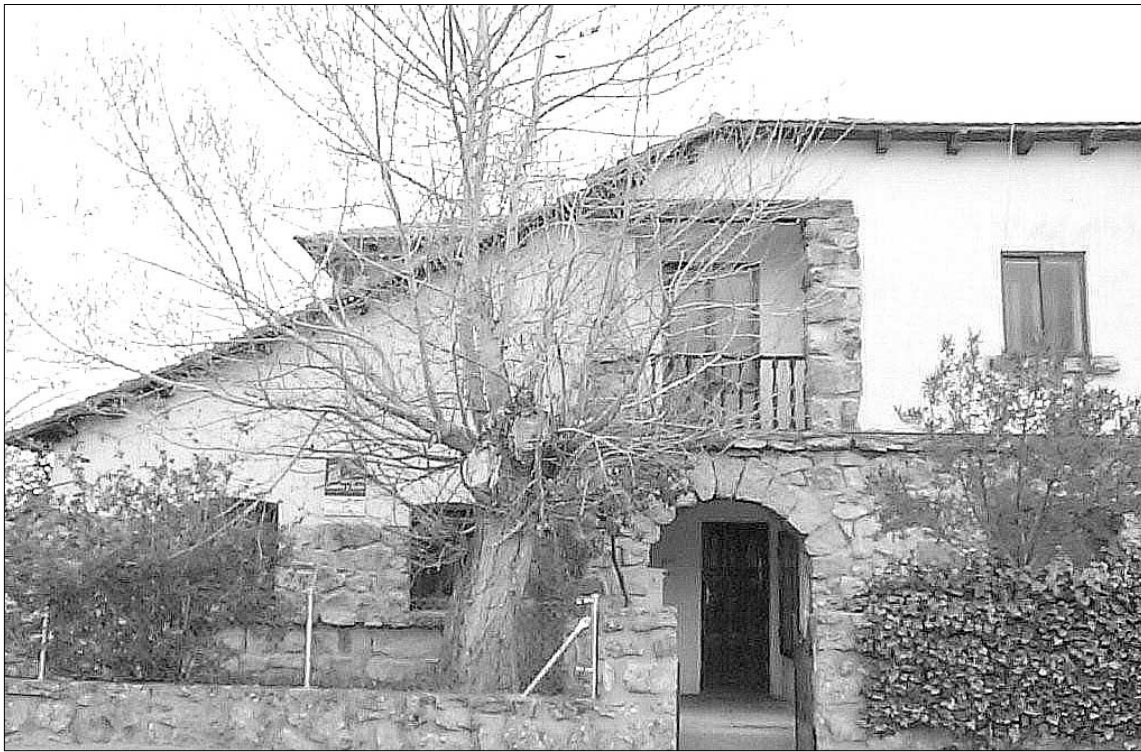
Las obras en el interior del antiguo consultorio ya están comenzadas y se prevén concluir para comienzos de octubre. / A.P.
