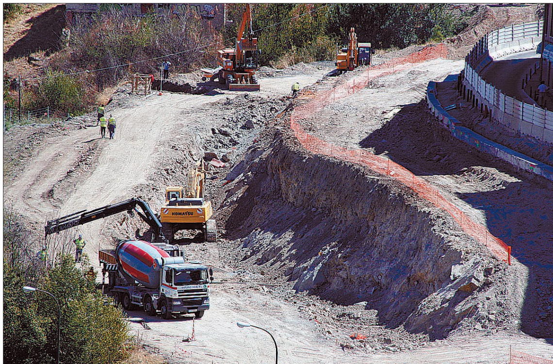
Fotografía tomada ayer de las obras de excavación del que será el mayor parking de Segovia / FERNANDO PEÑALOSA
