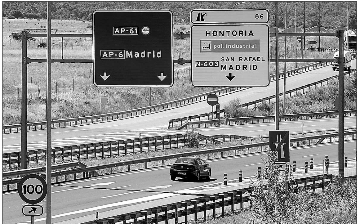
Los trabajos para dotar a la N-603 de una última capa de microaglomerado comenzarán la próxima semana. / KAMARERO
