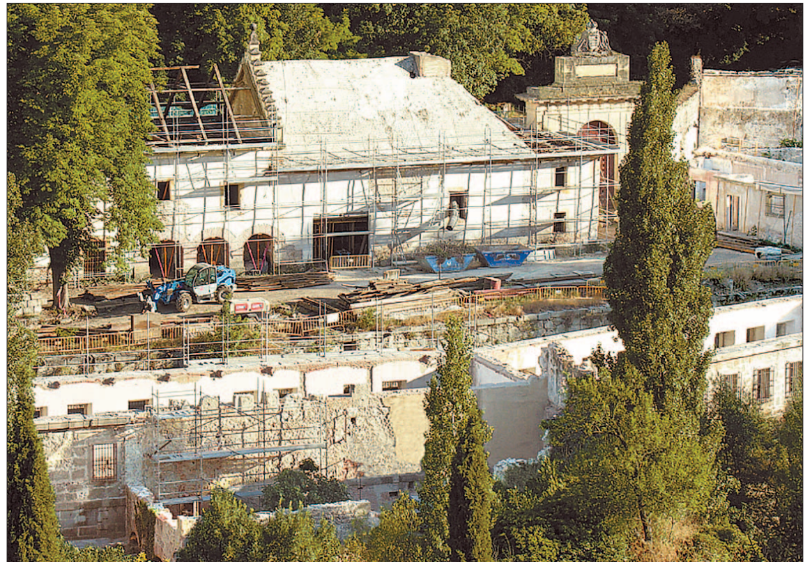
Una imagen reciente de la Casa de la Moneda, en la que las obras de rehabilitación van avanzando. / EL ADELANTADO
