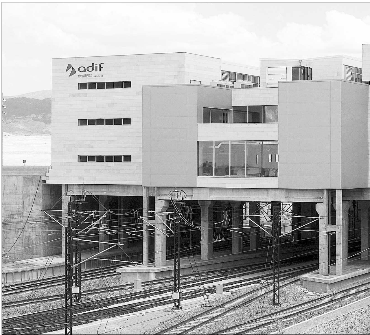
Las obras de la estación del AVE en las inmediaciones de la ermita de Juarrillos se encuentran en su última fase de ejecución y se darán por fi
