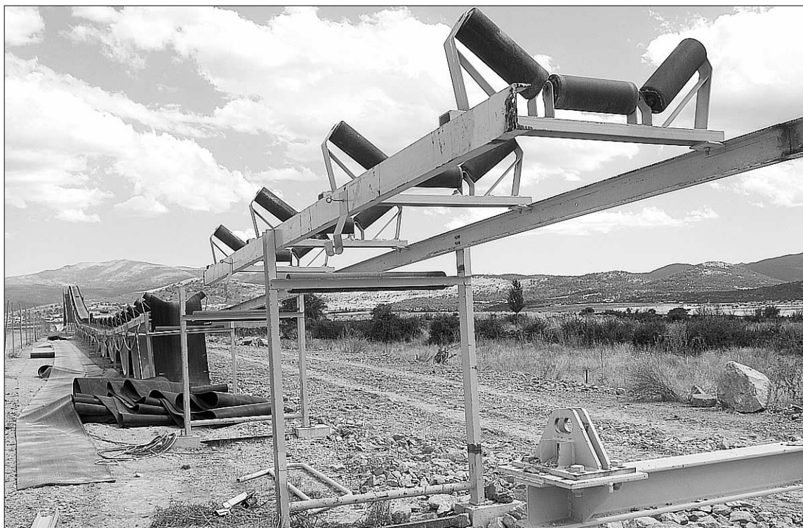
La cinta transportadora de escombros ha comenzado a ser desmontada./KAMARERO
