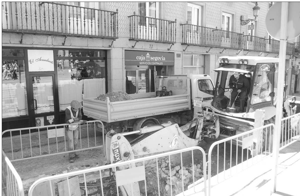
Foto de archivo del comienzo de las excavaciones para instalar los contenedores soterrados en Santa Engracia. / KAMARERO
