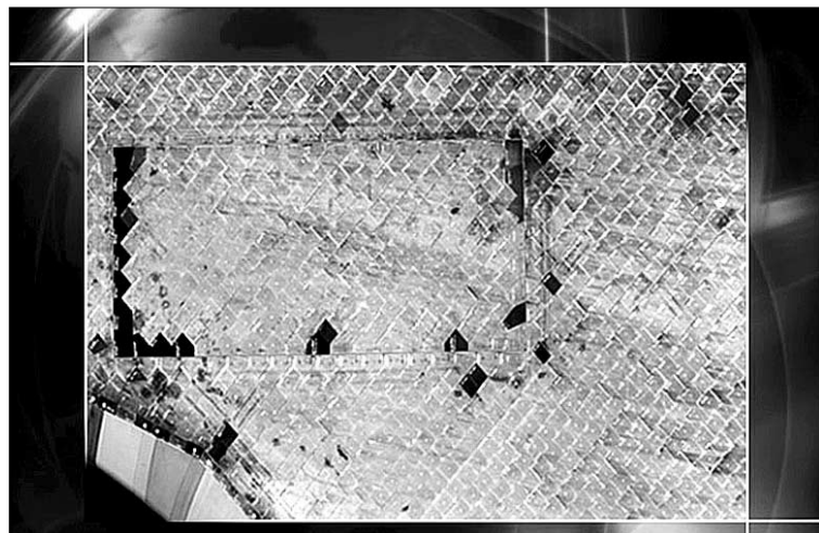
Primer plano de la grieta descubierta en el 'Endeavour'. / EFE
