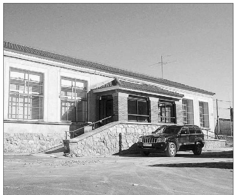
Los trabajos de reforma se centran en el interior del antiguo colegio. / A. PINELA
