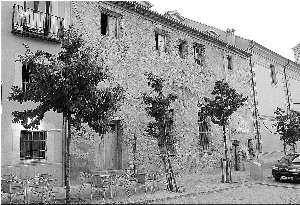
Inmueble en el que se ubicará el futuro albergue de La Granja, enfrente del Ayuntamiento. /F. PEÑALOSA
