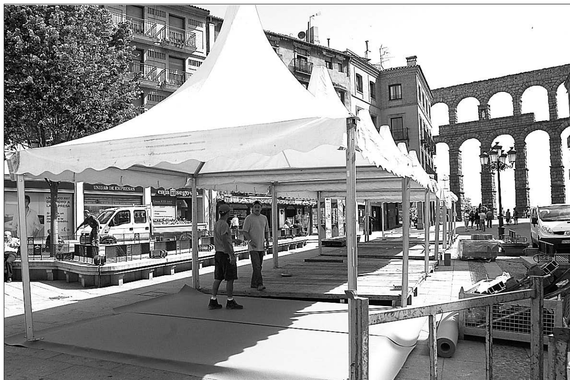
La organización llevó a cabo ayer el montaje de las carpas en la avenida Fernández Ladreda. /JUAN MARTÍN
