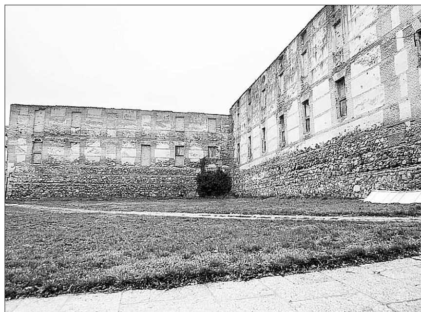
Aspecto antiguo y moderno del Parador de Turismo y del Centro de Convenciones de San Ildefonso
