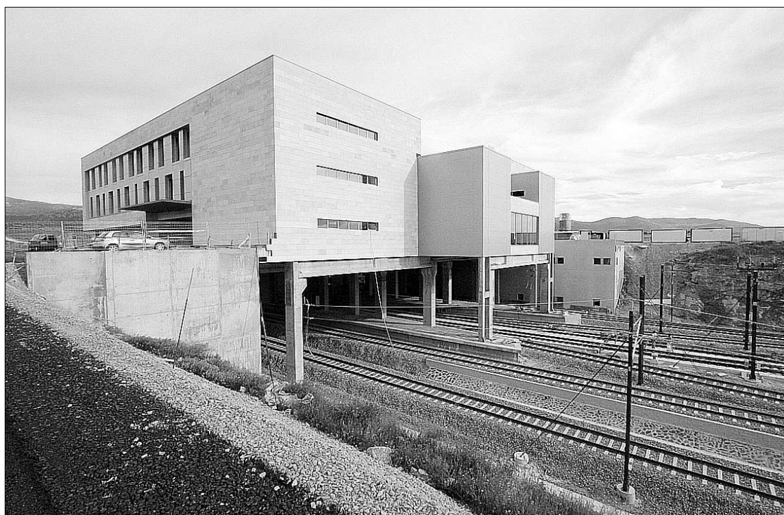
Las obras de la nueva estación, junto a la ermita de Juarrillos, se encuentran prácticamente terminadas. / FERNANDO PEÑALOSA
