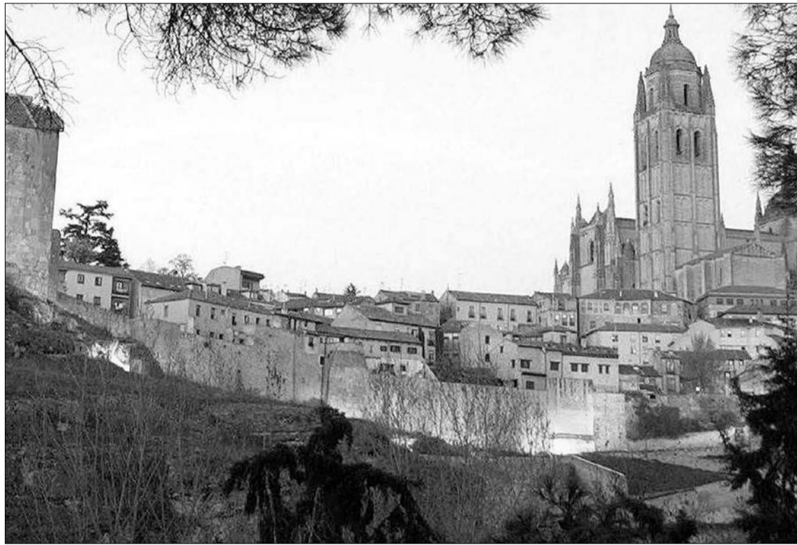
La muralla cuenta con una longitud de unos 3.400 metros y un total de 80 cubos, distanciados entre 25 y 40 metros/F.P.
