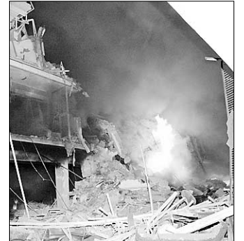
Incendio en el edificio.
