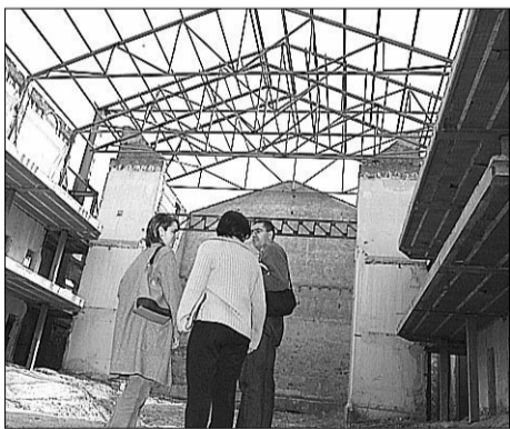
Aspecto actual del interior del Cervantes.
