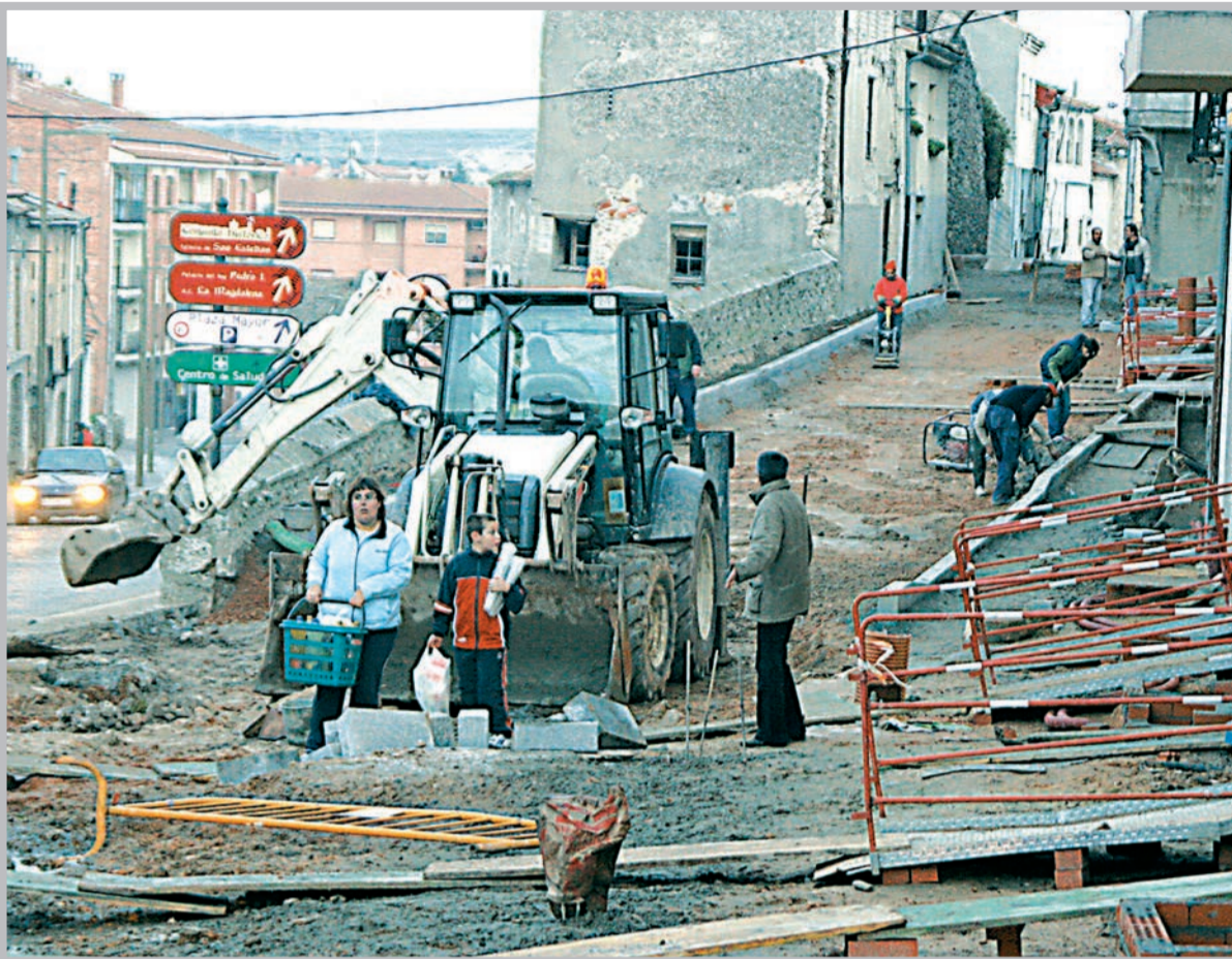
Obras. Barrio de San Andrés/ GABRIEL GÓMEZ
