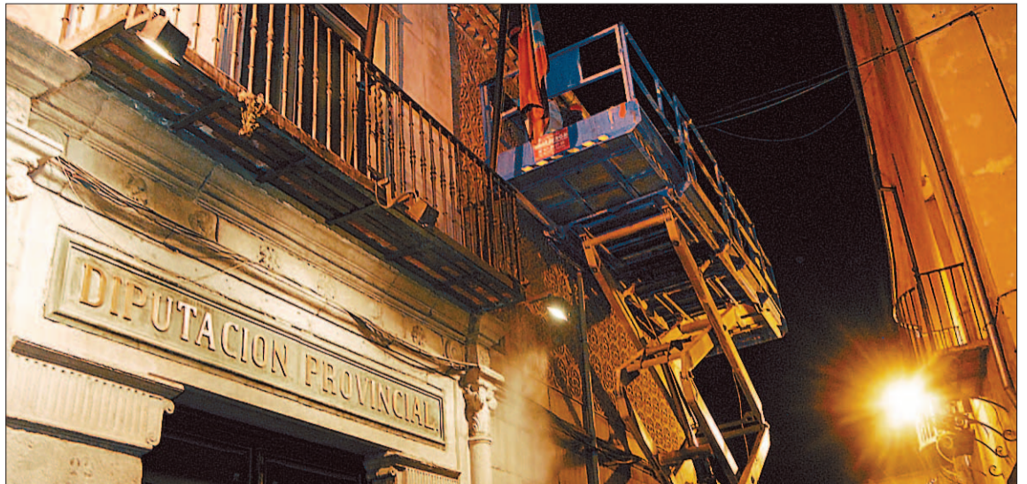
Plataforma elevada y móvil que se está utilizando en el paso estrecho entre la Diputación y el palacio de Quintanar./KAMARERO
