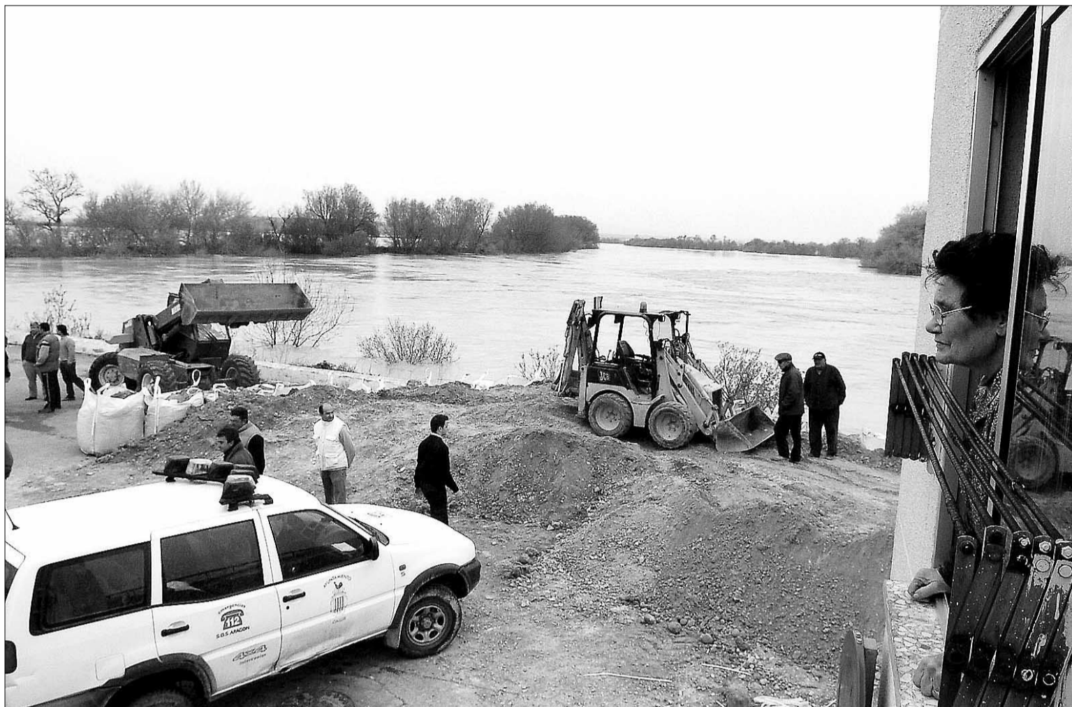
Una mujer observa las labores de refuerzo de un dique para contener las aguas del Ebro a su paso por la localidad zaragozana de Gallur. / JAVIER CEBOLLADA (EFE)
