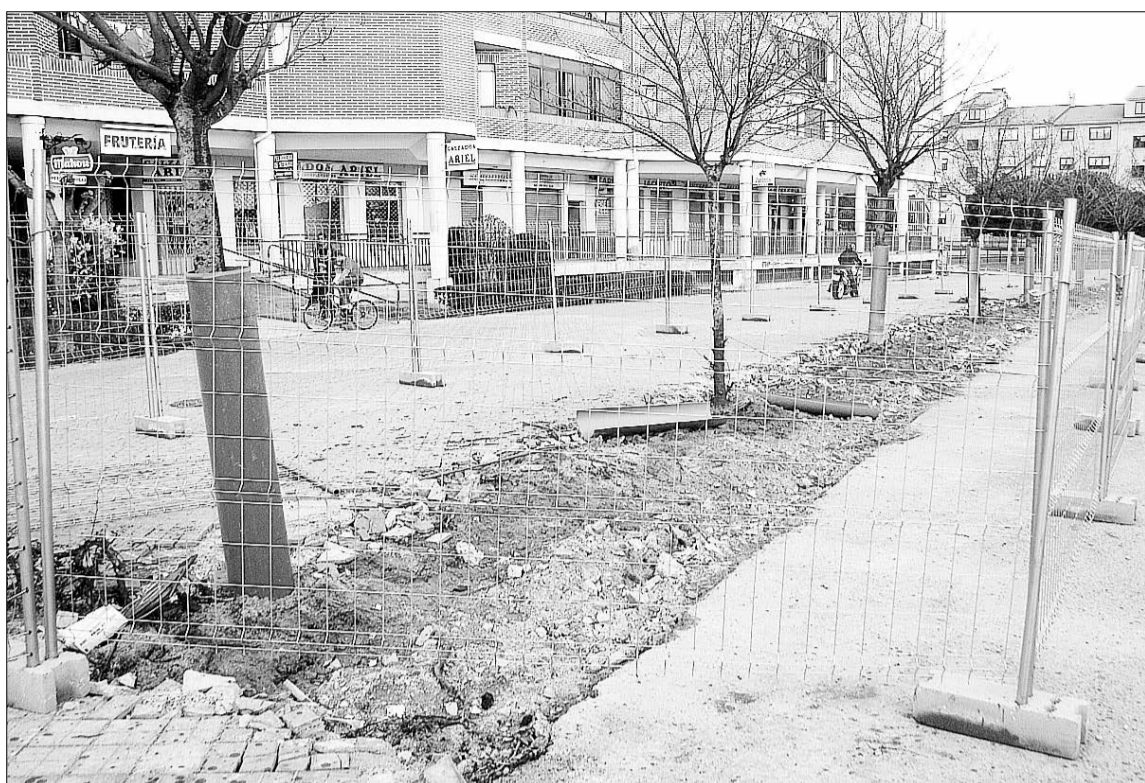
Aspecto de parte de la avenida Vicente Aleixandre, con la acera en obras para hacer aparcamientos en batería. / KAMARERO
