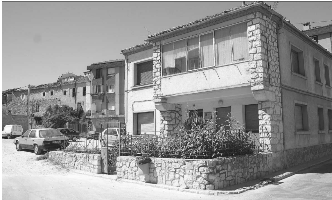
El módulo de albañilería actuará en la recuperación de la Casa del Secretario, propiedad de la Comunidad./GABRIEL GÓMEZ
